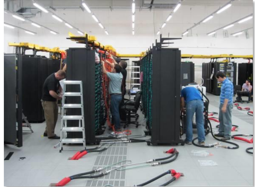
Warmwasserfüllung der Racks
