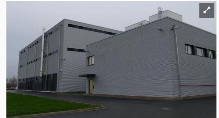
Neues Rechenzentrum von Volkswagen Financial Services im Braunschweiger Gewerbegebiet Rautheim
